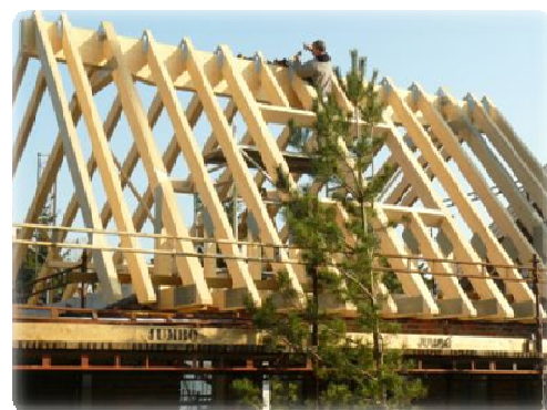
Tagkonstruktion i limtræ fra ombygning ved Greve Strand
