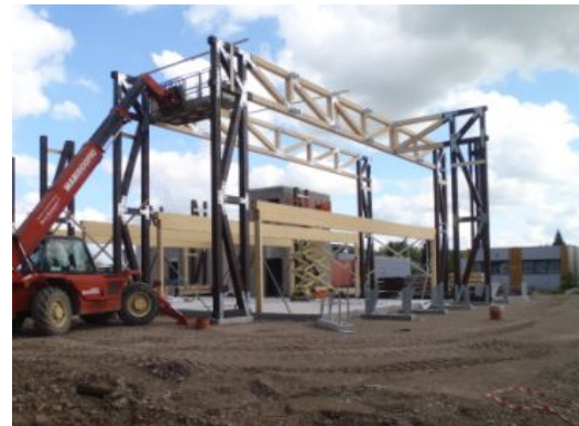
Montering af gitterrammer
