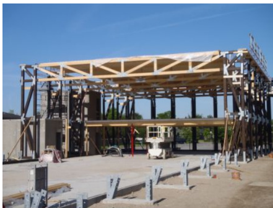
Gitterkonstruktion udført i 200x200 mm tømmer
