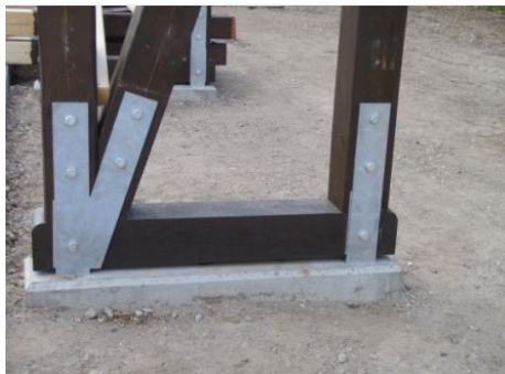
Eks på konstruktionsløsning ved rammeben (BH)
