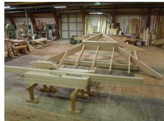
Præfabrikeret tagkonstruktion i limtræ klar til montage.
